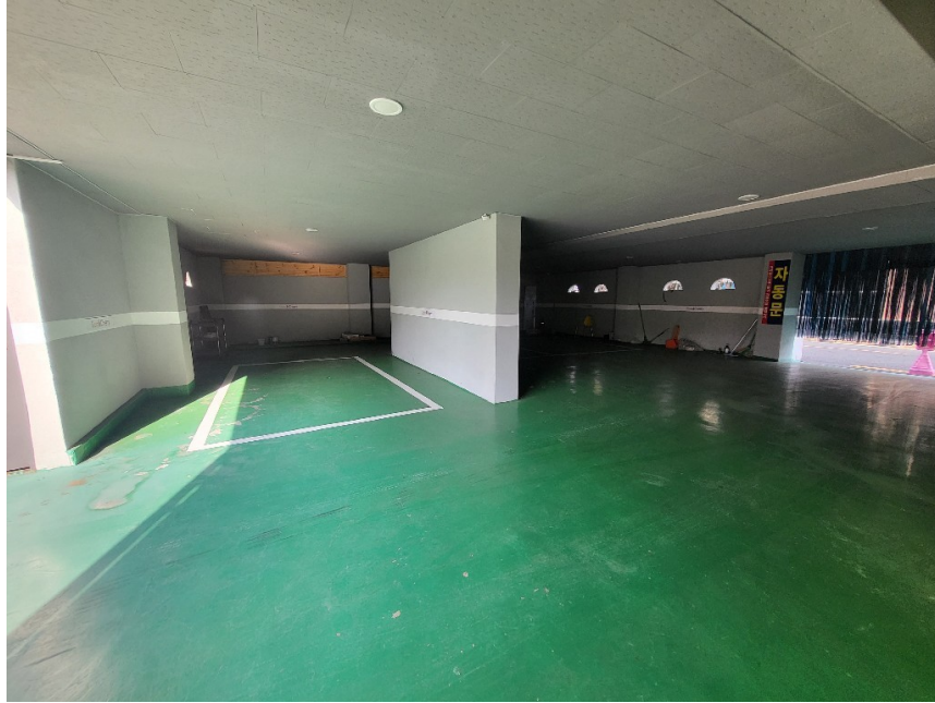
1층 주차장 전경
