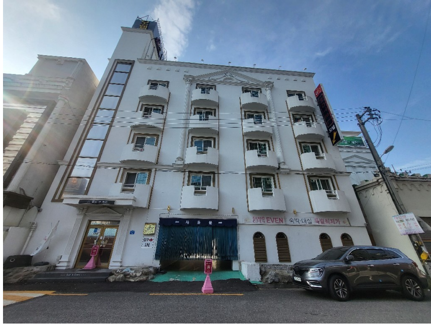
본건 전경(북동측에서 촬영)
